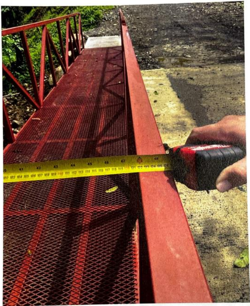
Imagen No.4 – Pasarela peatonal existente de 1.21 m de ancho (cumple Ley 7600) Fuente: propia
