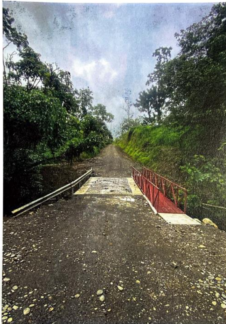
Imagen No.3 – Paso vehicular existente de 4.70 m de ancho Fuente: propia
