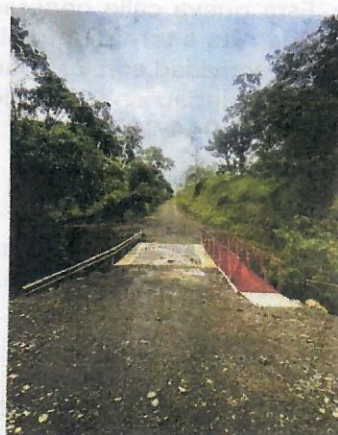
Imagen No. 3 - Paso vehicular existente de 4,70 m de ancho Fuente: propia
